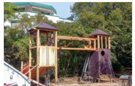
Die Bauarbeiten am neuen Spielgestell im September
