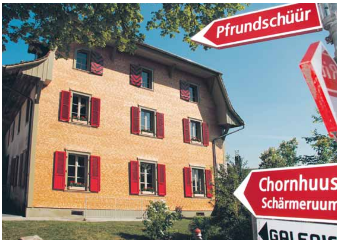
Das Chornhuus auf dem Schlossareal Köniz: Die Stirnfassade präsentiert sich in neuem Glanz.
