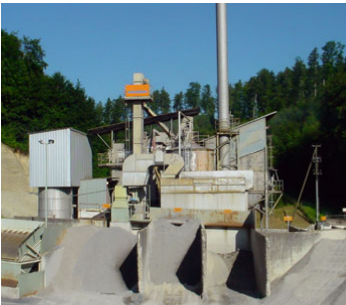
Das alte Belagswerk wurde 2008/09 abgebrochen.
