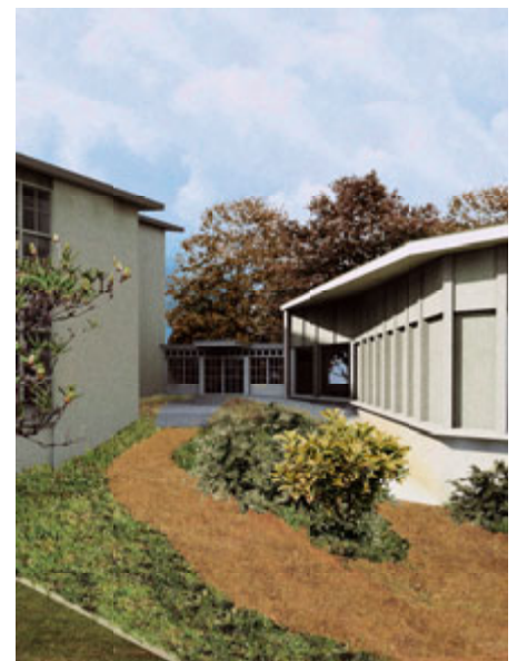
Detail Übergang von alt zu neu
