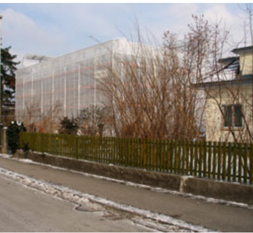
In Bau (5 Wohnungen anstelle 1-Fam.-Haus): Alpenstrasse 35 Bild pp
