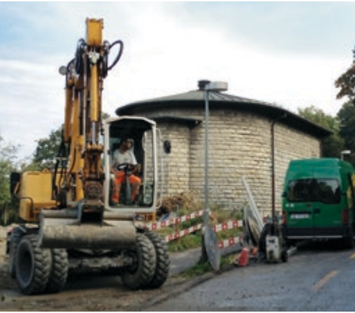
Wegen Bau- und Rohrverlegungsarbeiten gesperrt.
