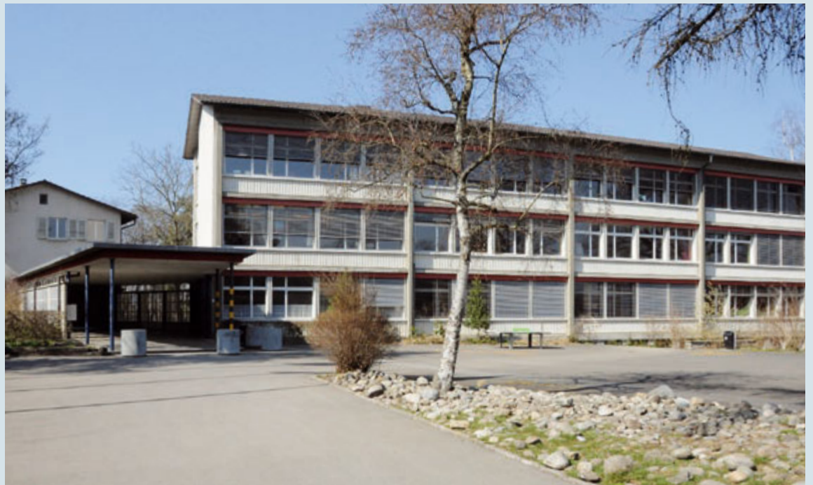
Das Schulhaus Wandermatte wird zur Zeit saniert, stösst aber trotzdem an seine Kapazitätsgrenzen.
