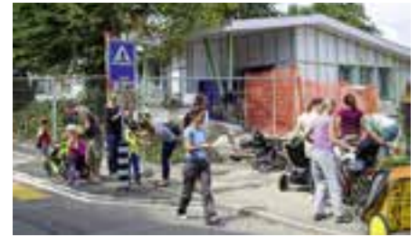
Provisorischer Kindergartenausgang auf die Eichholzstrasse: Spezielle Vorsicht!
