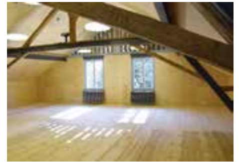
Das neu ausgebaute Dachgeschoss eignet sich für den Musikunterricht.
