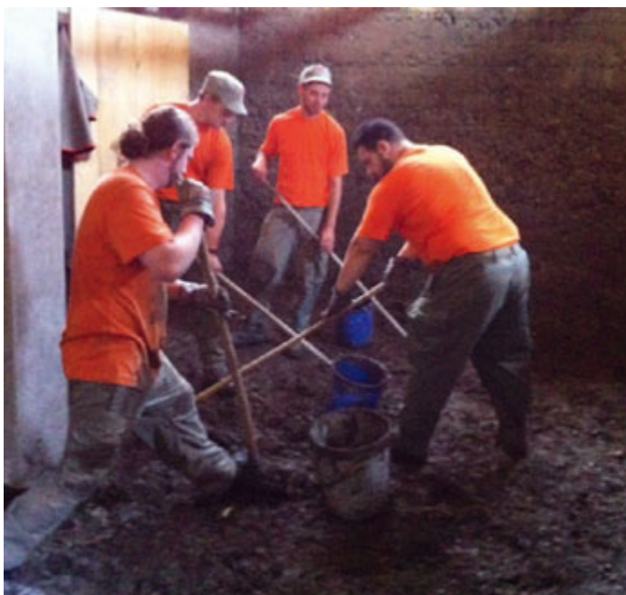
Entfernen von Schlamm aus einem Stall
