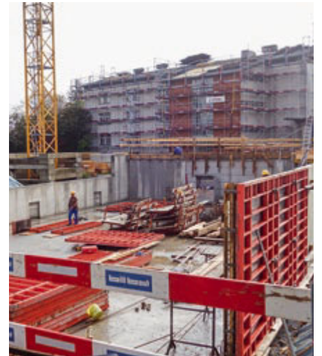
Stand der Bauarbeiten Mitte Oktober – zwei Monate später soll der Rohbau bereits stehen Bild pp
