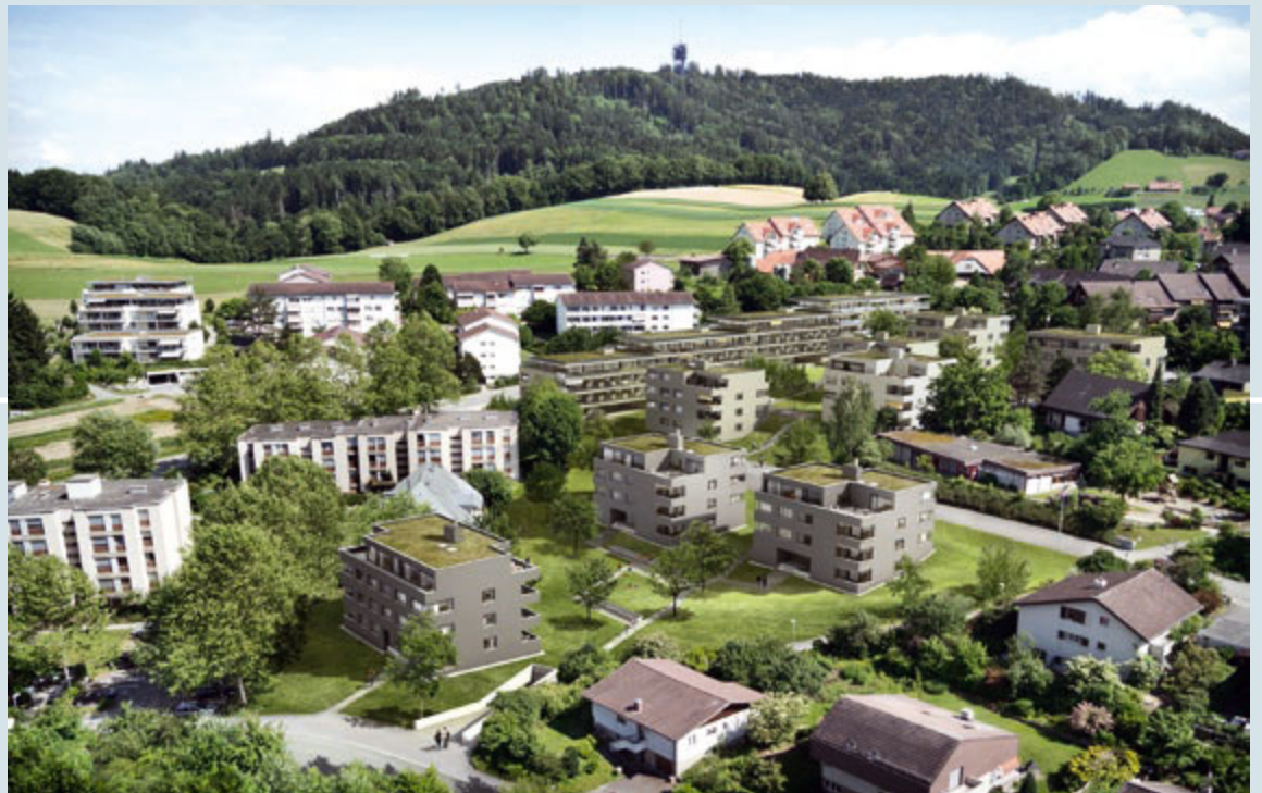
Wohnen in Hertenbrünnen: Auf Land der Gemeinde Köniz entstand in den letzten Jahren diese neue Wohnüberbauung.
