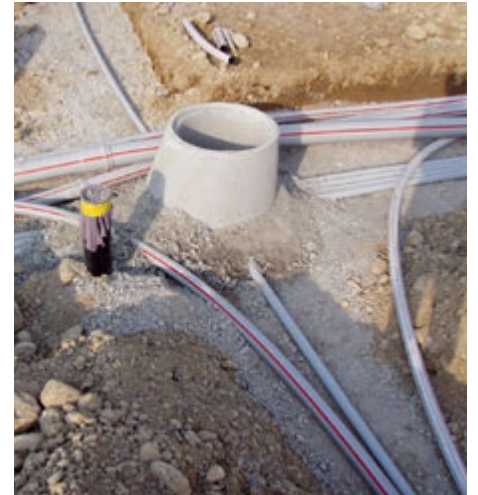
Bild oben: Offener Graben mit Elektro- und Kabelkommunikationsrohren und Schacht
