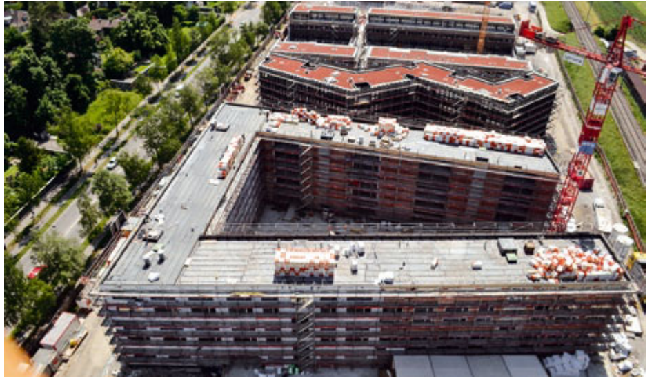
Blick vom Hochhaus-Kran auf die Baustelle anfangs Juni
