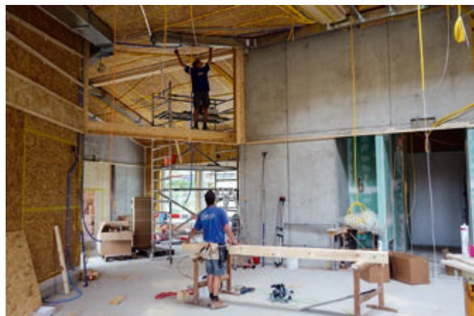
Neuer Mehrzwecksaal / Musikraum: Noch geben die Handwerker den Ton an
