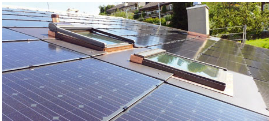
Bei Solaranlagen gilt es bestimmte Wartungsmassnahmen zu beachten: Der Solaranlagencheck der SSES bietet professionelle Beratung.
