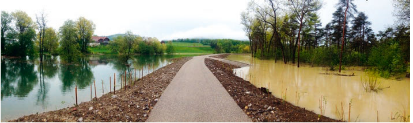
Hochwasseralarm im Mai 2015 mit fast 500 m 3 /sec: Die neuen Dämme bewähren sich – Flugplatz, Kulturland und Trinkwasserfassungen blieben verschont Bild zvg Tiefbauamt des Kantons Bern
