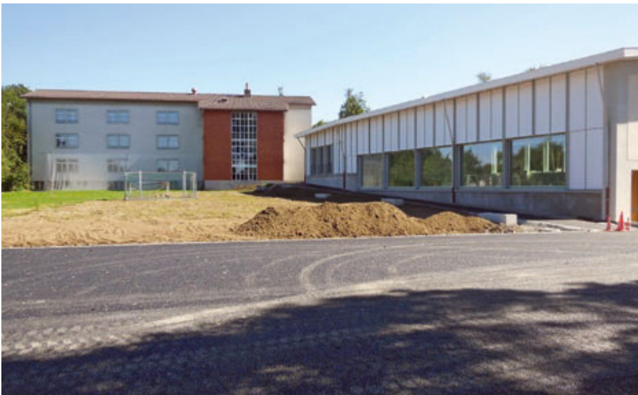
Unveränderte Fassade des Klassentraktes; rechts der neue Sporttrakt mit Mehrzweckraum.
