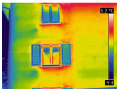
Wärmebilder decken allfällige energetische Schwachstellen in der Gebäudehülle auf.
