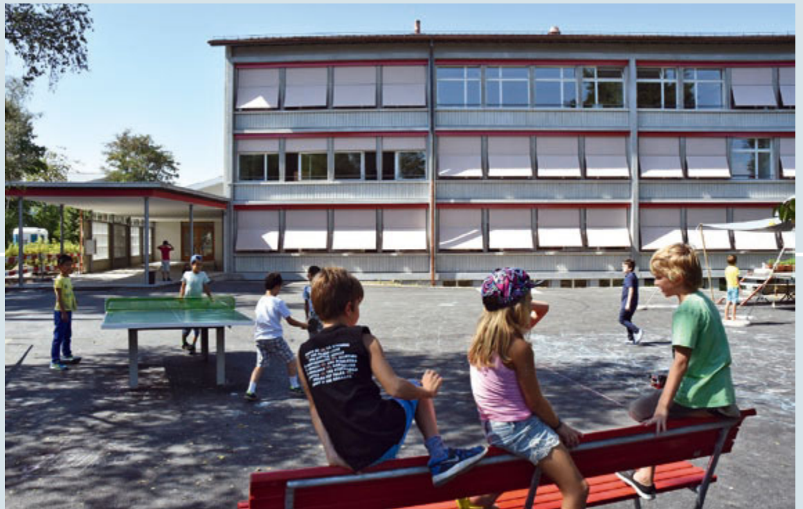
Pausenzeit beim Schulhaus Wandermatte. Die sanierte und erweiterte Schulanlage wurde nach den Sommerferien in Betrieb genommen. © DANIEL BILL
