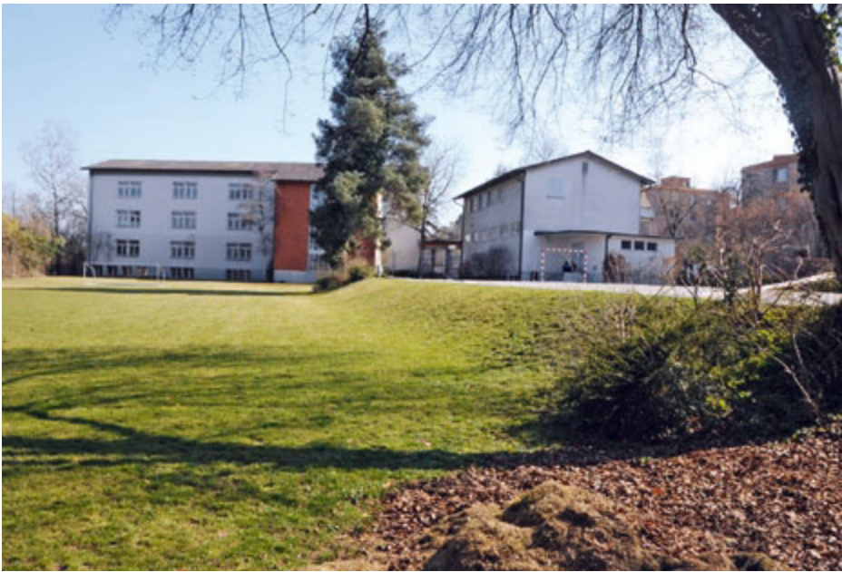
Rückfassade des denkmalgeschützten, 60-jährigen Klassentraktes; rechts der abgebrochene Turnsaal und der Hauswartwohnung.
