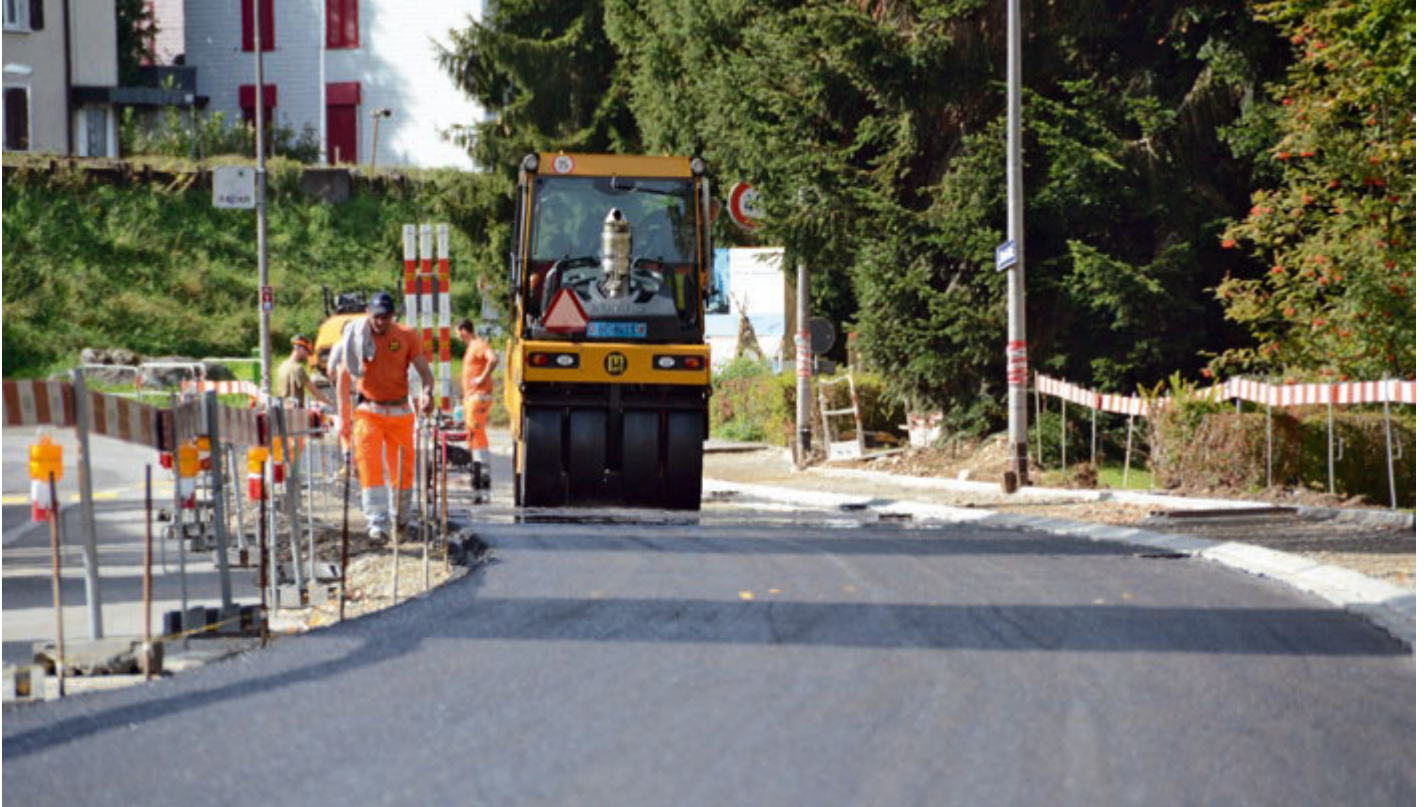
Es wird gegraben, gebaut und asphaltiert an der Kirchstrasse.
