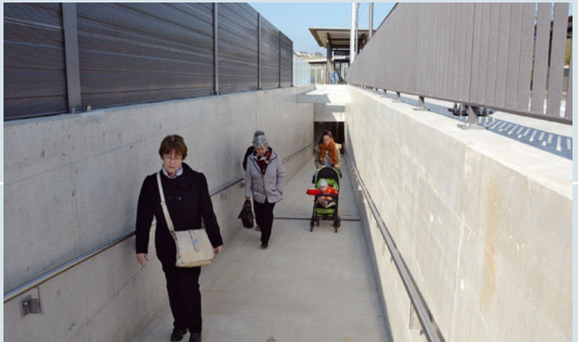
Rampe statt Treppe: Der neue Perron-Zugang am Bahnhof Oberwangen ist gebaut. Beharrlichkeit führte auch bei diesem Beispiel zum Ziel.
