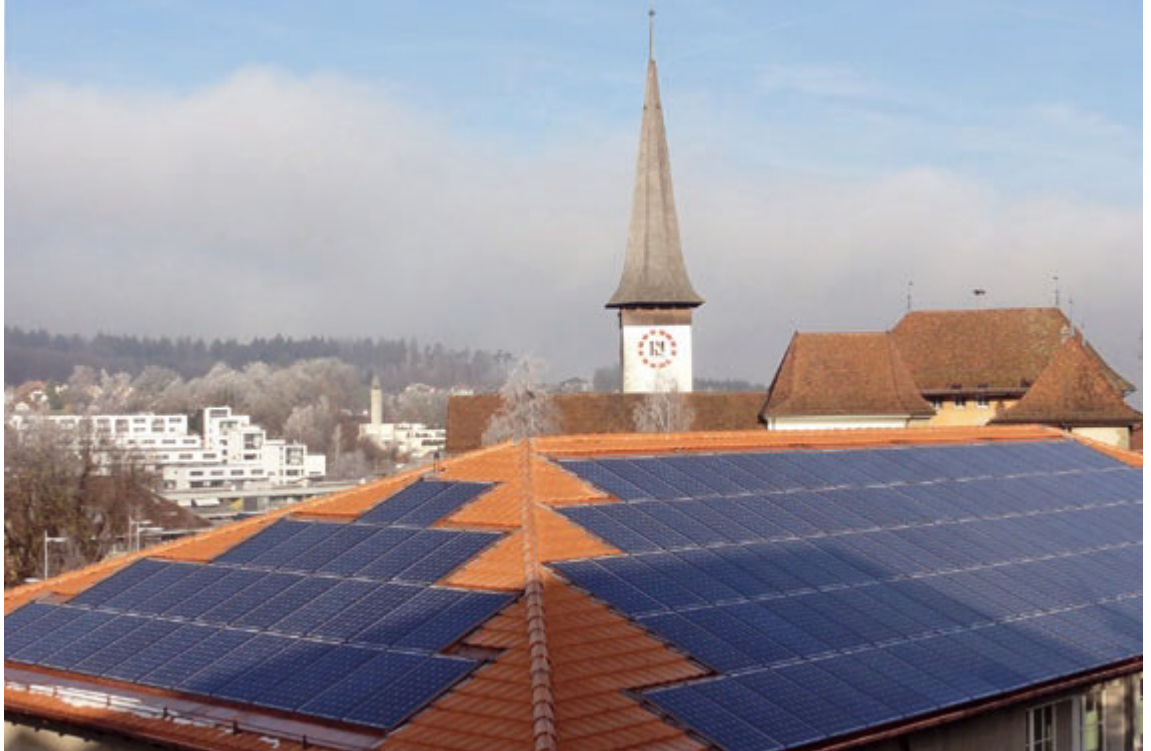
Oberstufenzentrum Köniz: Auch hier wurde eine Photovoltaik-Anlage zur Energiegewinnung installiert.
