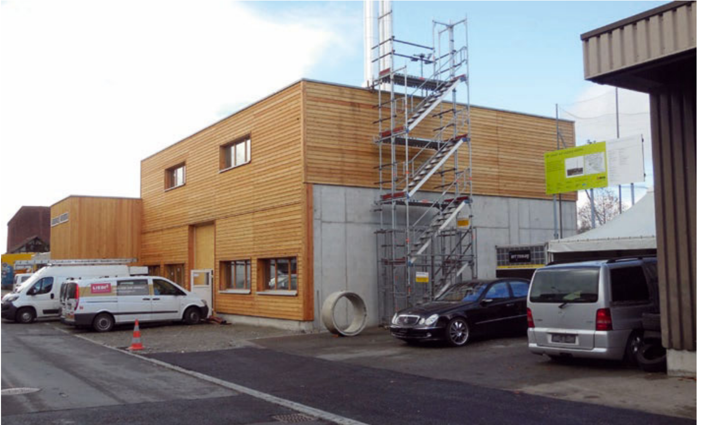
Die fast vollendete Holzheizzentrale an der Gaselstrasse in Schliern.
