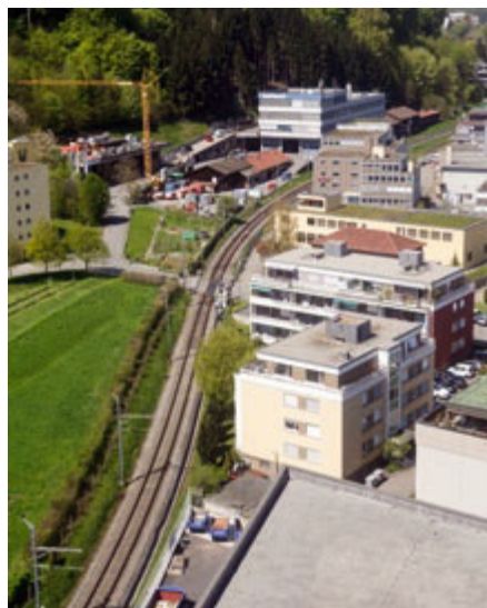
Doppelspurausbau in zum Teil engen und kurvigen Verhältnissen als echte Herausforderung Bild pp
