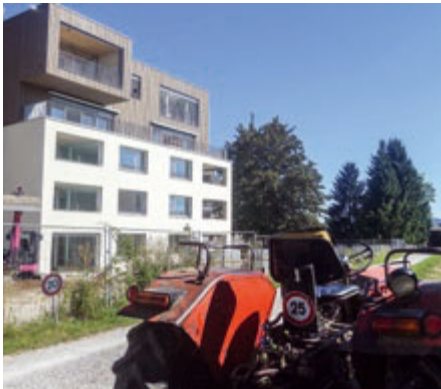
Aufstockung mittels Holz-Leichtbau-Fertigelementen: Moderner Touch in Nachbarschaft zur Landwirtschaft
