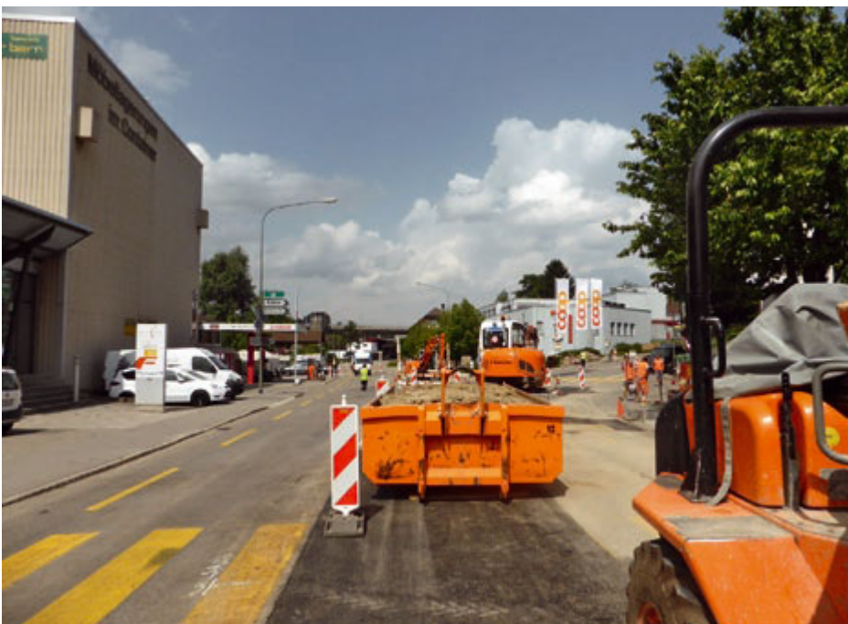
Die Arbeiten an der Freiburgstrasse laufen auf Hochtouren.
