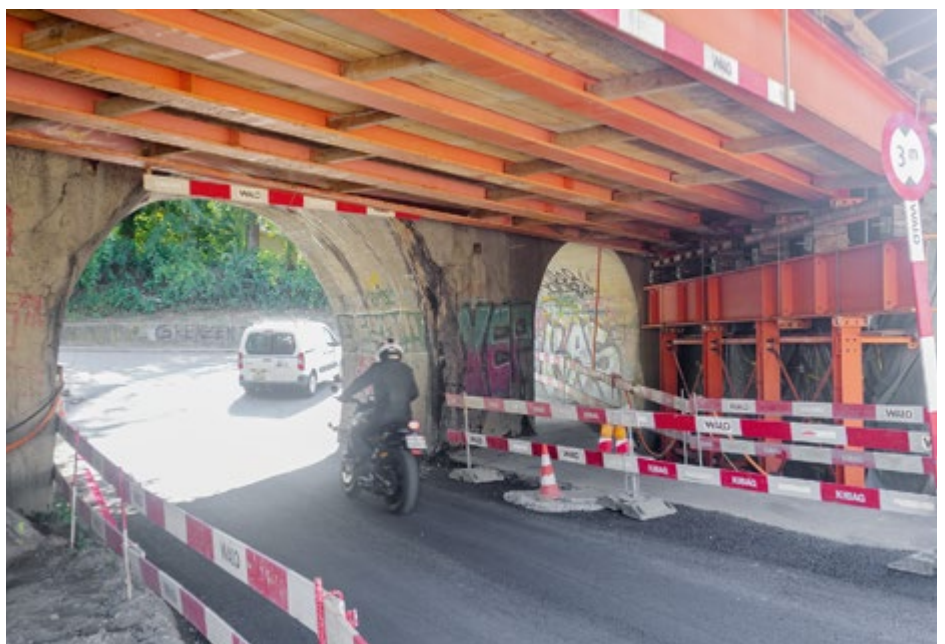
Nadelöhr, Unterführung Kirchstrasse: Bald Vergangenheit
