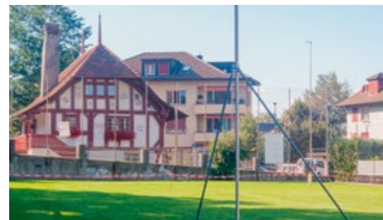
Der Neubau ist zur Schulhausaltbaute hin 3-geschossig, hingegen zur Dorfstrasse hin aus Ortsbildschutzgründen nur 2-geschossig geplant. Bild pp
