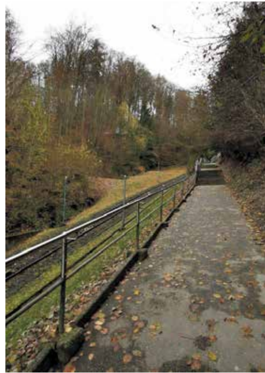
So sah's bis vor Kurzem oberhalb der Talstation noch aus Bild zvg
