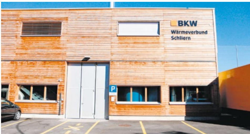
Die Heizzentrale in Schliern.
