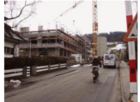
Baustelle an der oberen Weyerstrasse: MFH anstelle zweier EFH
