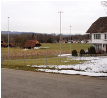
Bauprofile an der Weyerstrasse 32
