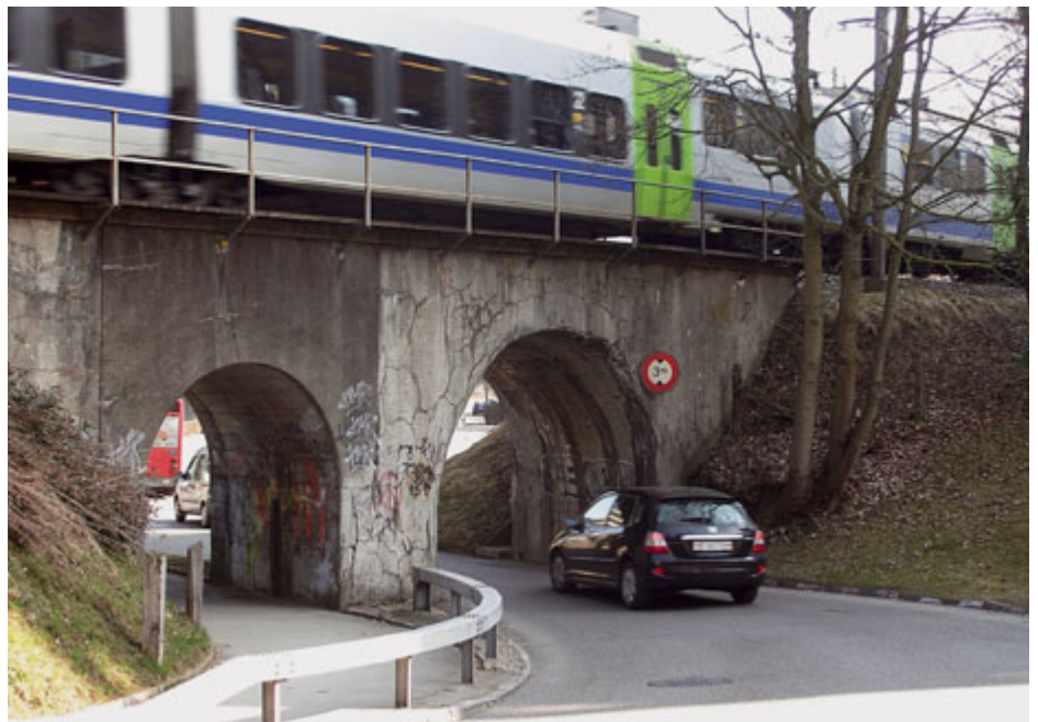
Der Engpass Kirchstrasse wird bis 2019 behoben
