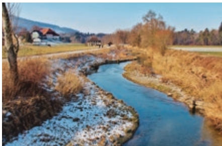
Hier werden neue Leitungen verlegt. Revitalisierte Gürbe mit bestehender Rohrbrücke im Hintergrund.
