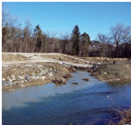
Der neue Aaredamm steht
