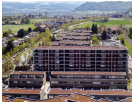
Blick vom Hochhaus über die Baufelder C–E hinweg auf die Berge
