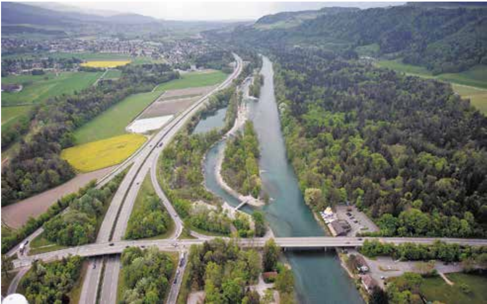
Die Aufweitung des Flusslaufs in der Hunzikenau und der Bau eines Hochwasserschutz- damms entlang der Autobahn stellten 2006 die erste Etappe im Rahmen des Konzepts «aarewasser» dar. Das Luftbild illustriert den begrenzten Handlungsspielraum für eine Aufwertung der Flusslandschaft. Bild wikipedia
