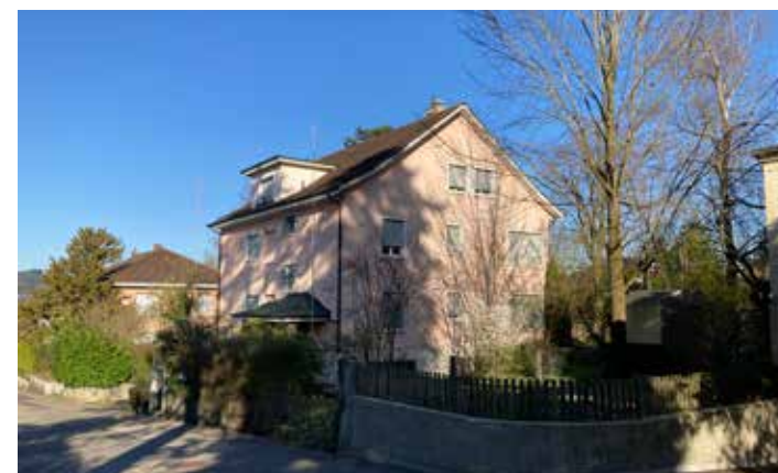
Mattenweg 6: Abbruch des bestehenden Dreifamilienhauses, Neubau zweier Sechsfamilienhäuser inkl. Einstellhalle.
