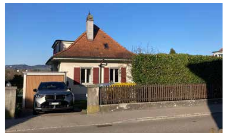
Alpenstrasse 25: Abbruch des bestehenden Einfamilienhauses inkl. Garage, Neubau Einfamilienhaus. (Bilder mf)
