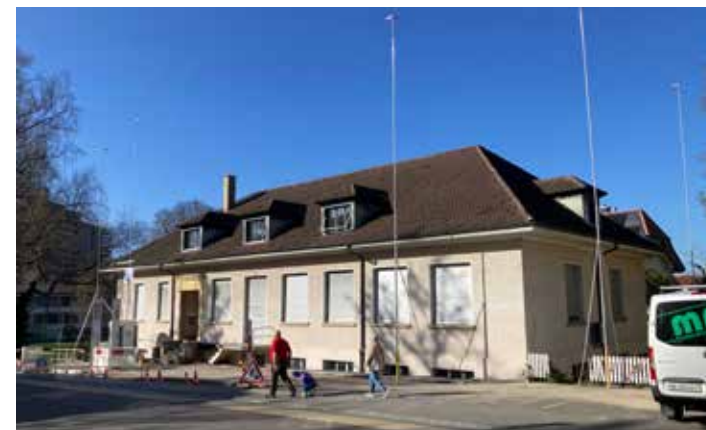
Kirchstrasse 175: Abbruch des bestehenden Gebäudes, Neubau eines Mehrfamilienhauses (14 Wohnungen) inkl. Einstellhalle.
