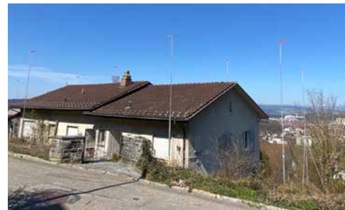
Grünenbodenweg 2/2a: Abbruch der bestehenden Liegenschaft, Neubau zweier Doppelreihenhäuser (4 Wohnungen und 4 Studios) sowie eines Zweifamilienhauses (2 Wohnungen) inkl. Tiefgarage.
