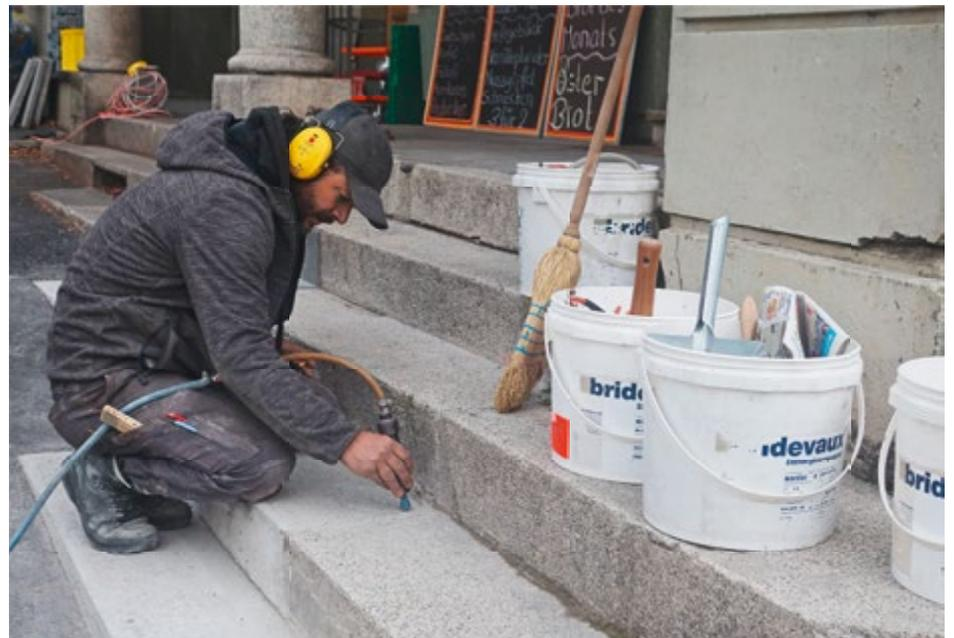
*Liebe zum Detail: Feinarbeiten am Treppenzugang zur Bäckerei – auf dass die neuen Betonstufen optisch den bestehenden Granitstufen ähneln*
