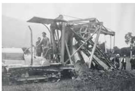
Kanalbau mittels Grabmaschine
